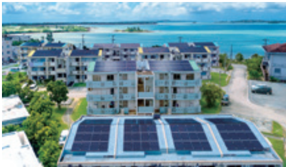
ソーラーパネルを設置した住宅外観
